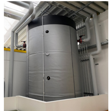
Pufferspeicher Pelletsheizung
