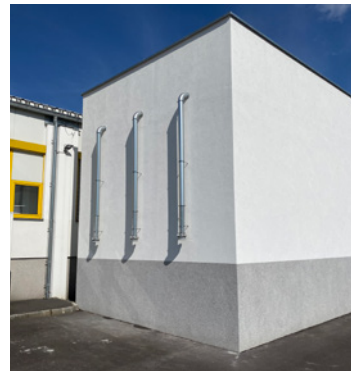
Anbau und Anspeisung Pelletslager
