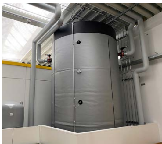
Pufferspeicher Pelletsheizung
